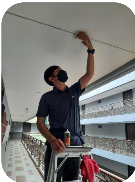
ภาพที่ 2-4.4(7) ตรวจสอบและบำรุงรักษาระบบป้องกันอัคคีภัยโดยผู้เชี่ยวชาญเป็นประจำทุกปี
